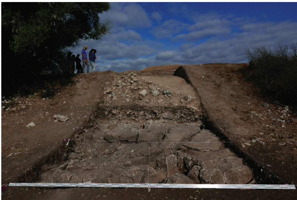
Figura 3 – Área 3, sondagem 1 – aspecto final da intervenção na plataforma inferior visualizando-se o substrato geológico e a entrada do algar.
